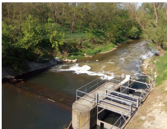
Dyje – v úseku odběru a vypouštění odpadních vod z JUBU
