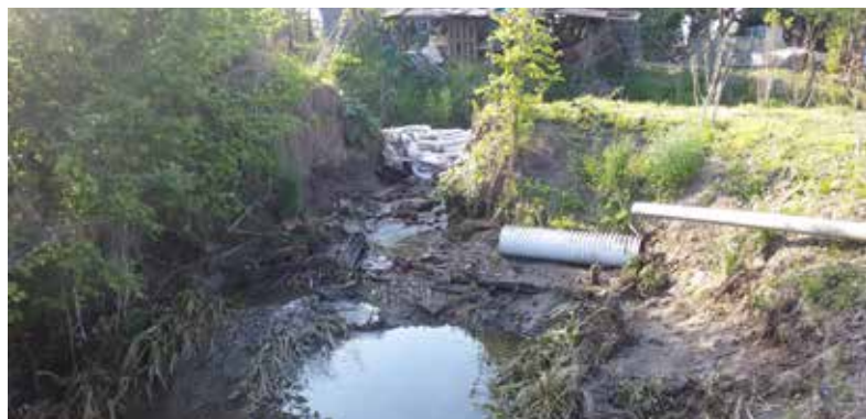
↑ Břeh Hamerského náhonu před provedením opravy
