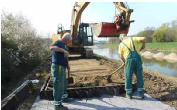
HRÁZ DYJE V BŘECLAVI MEZI ŽELEZNIČNÍMI MOSTY V PRŮBĚHU STAVBY
