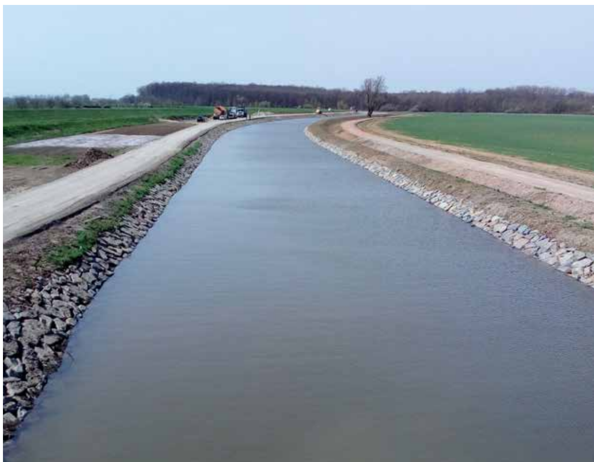
OPRAVENÉ BŘEHY BAŤOVA KANÁLU V ÚSEKU U VNOROV
