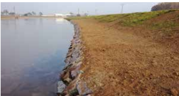
MORAVA, KOSTELANY, Ř. KM 139,740–142,550 OPRAVA NÁTRŽÍ
