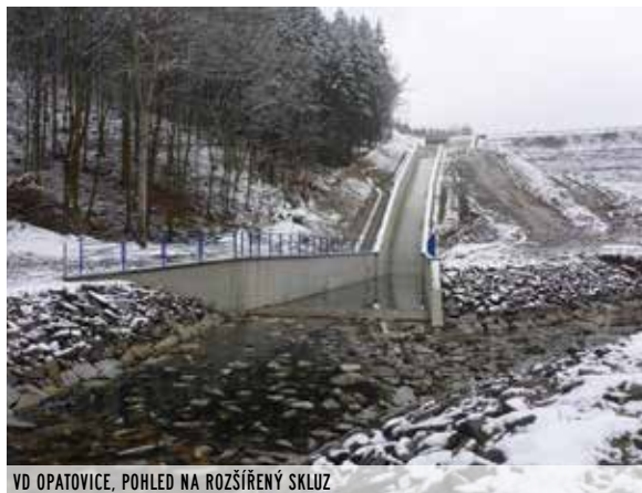
VD OPATOVICE, POHLED NA ROZŠÍŘENÝ SKLUZ
