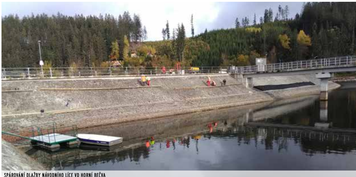
SPÁROVÁNÍ DLAŽBY NÁVODNÍHO LÍCE VD HORNÍ BEČVA
