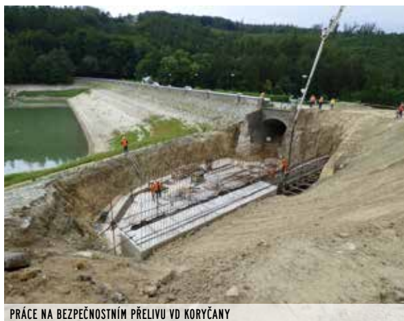
PRÁCE NA BEZPEČNOSTNÍM PŘELIVU VD KORYČANY
